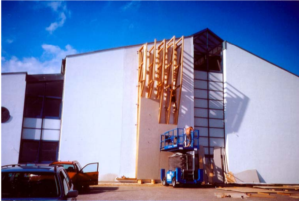
Montage der besandeten Panels (Platten) auf dem Holzfachwerk
