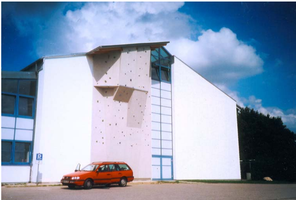
Die fertige Wand mit Dach, Dachrinne und Griffen (ab 3 Meter Höhe), ca. 90qm Kletterfläche und 12m Kletterhöhe.
