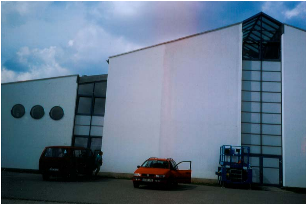
Außenwand der Mehrzweckhalle in Allershausen (Hollledau).
