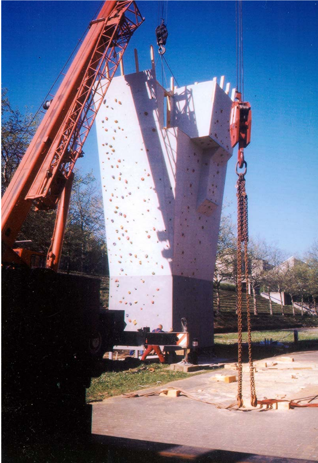
Aufstellung mit Hilfe von 2 Kränen und Verschweißung am Betonfundament.
