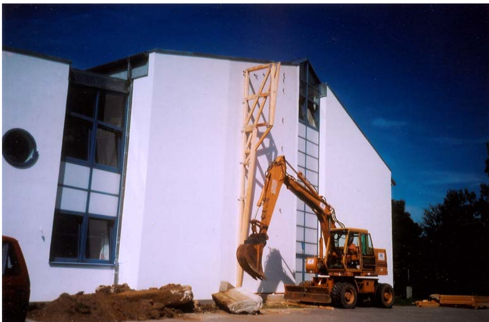
Unterkonstruktion in Holzfachwerk-Bauweise.
